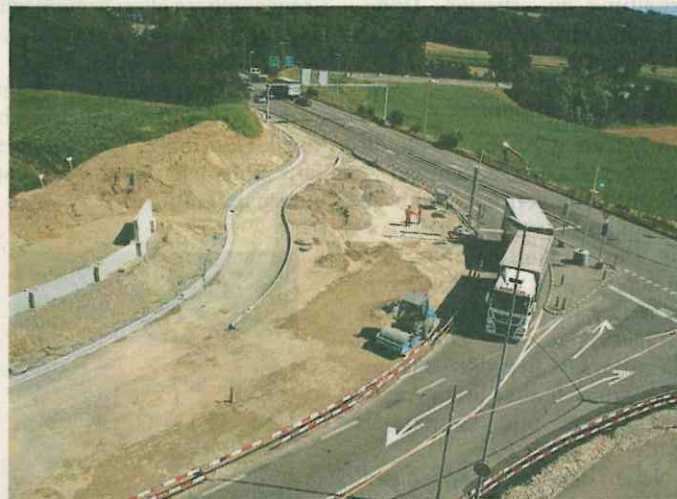
Georg-Renner-Strasse: Der Bypass zur Flawilerstrasse ist im Bau.
