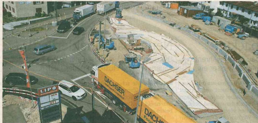
Flawilerstrasse: Bereits lassen sich die Ausmasse des künftigen Kreisels gut erkennen.
