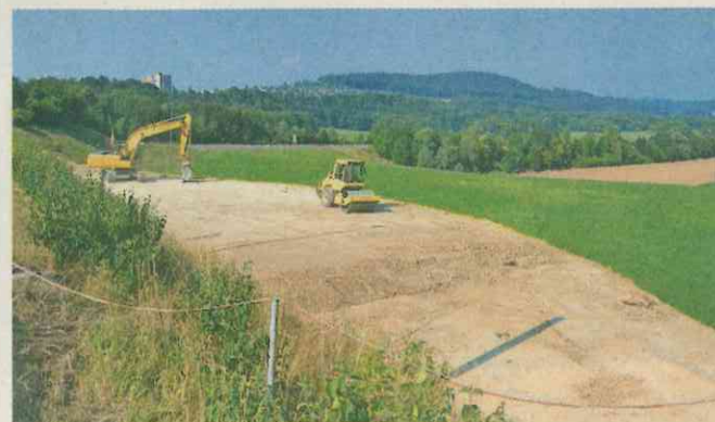
Ein Teil der Aufschüttung bei der Georg-Renner-Strasse ist erfolgt.
