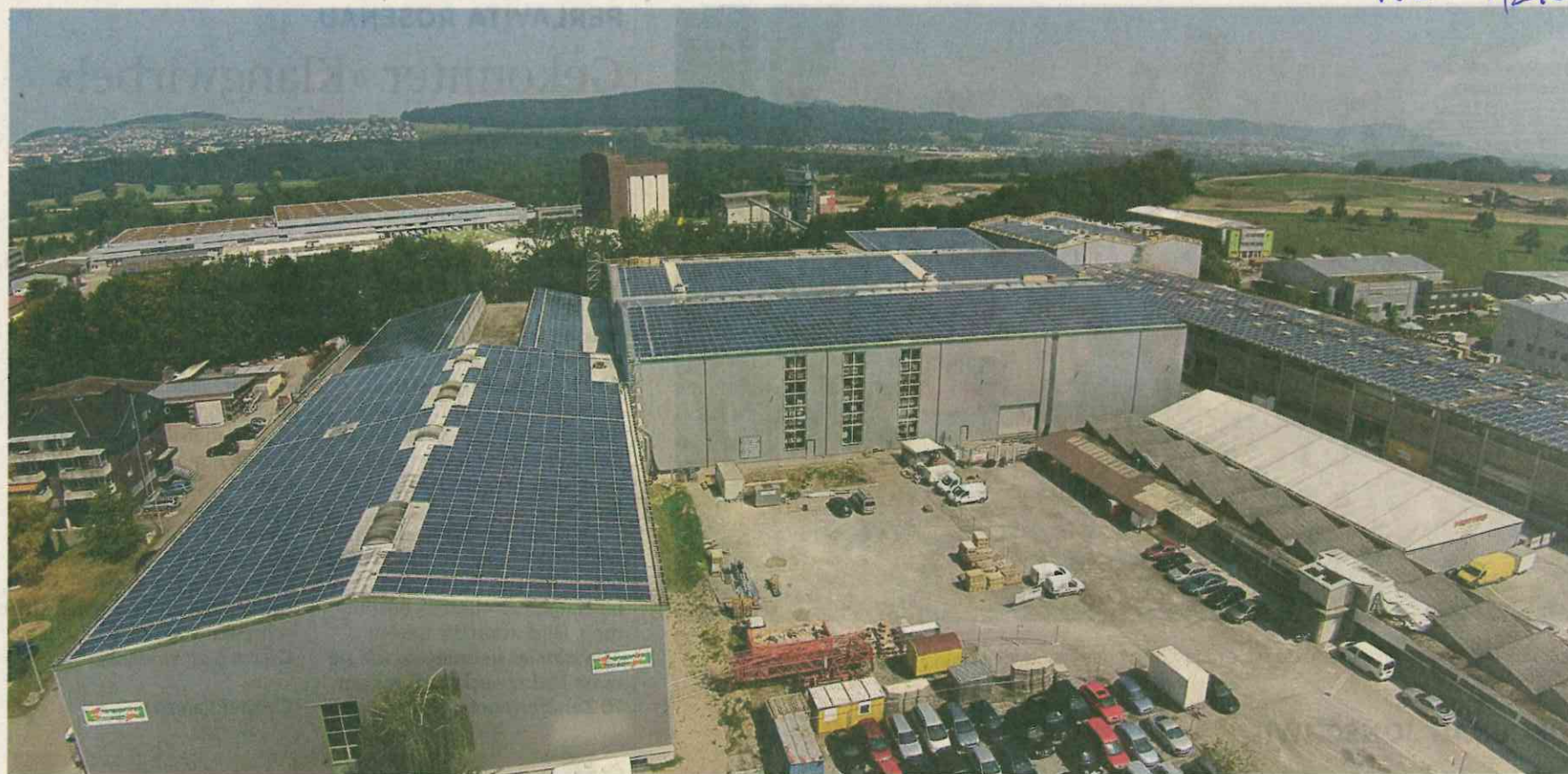
Auf den Hallendächern des Logistikcenters der Holenstein AG in Schwarzenbach wurden auf einer Fläche von rund 15 000 Quadratmetern Solarzellen montiert.
