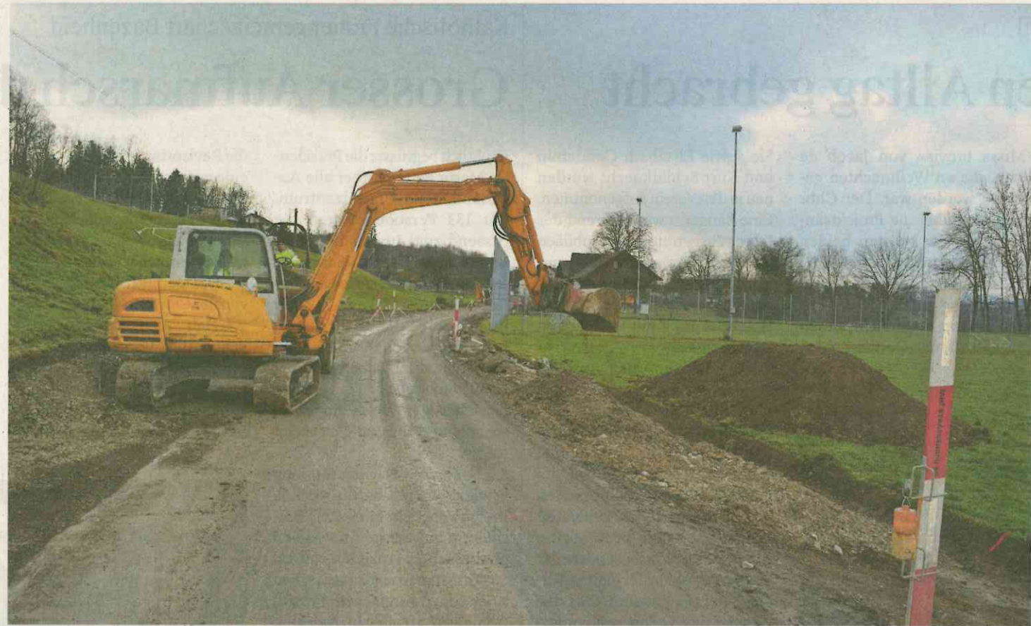
Bagger und andere Baumaschinen verrichten bereits vor dem Ortseingang in Niederstetten ihren Dienst.
