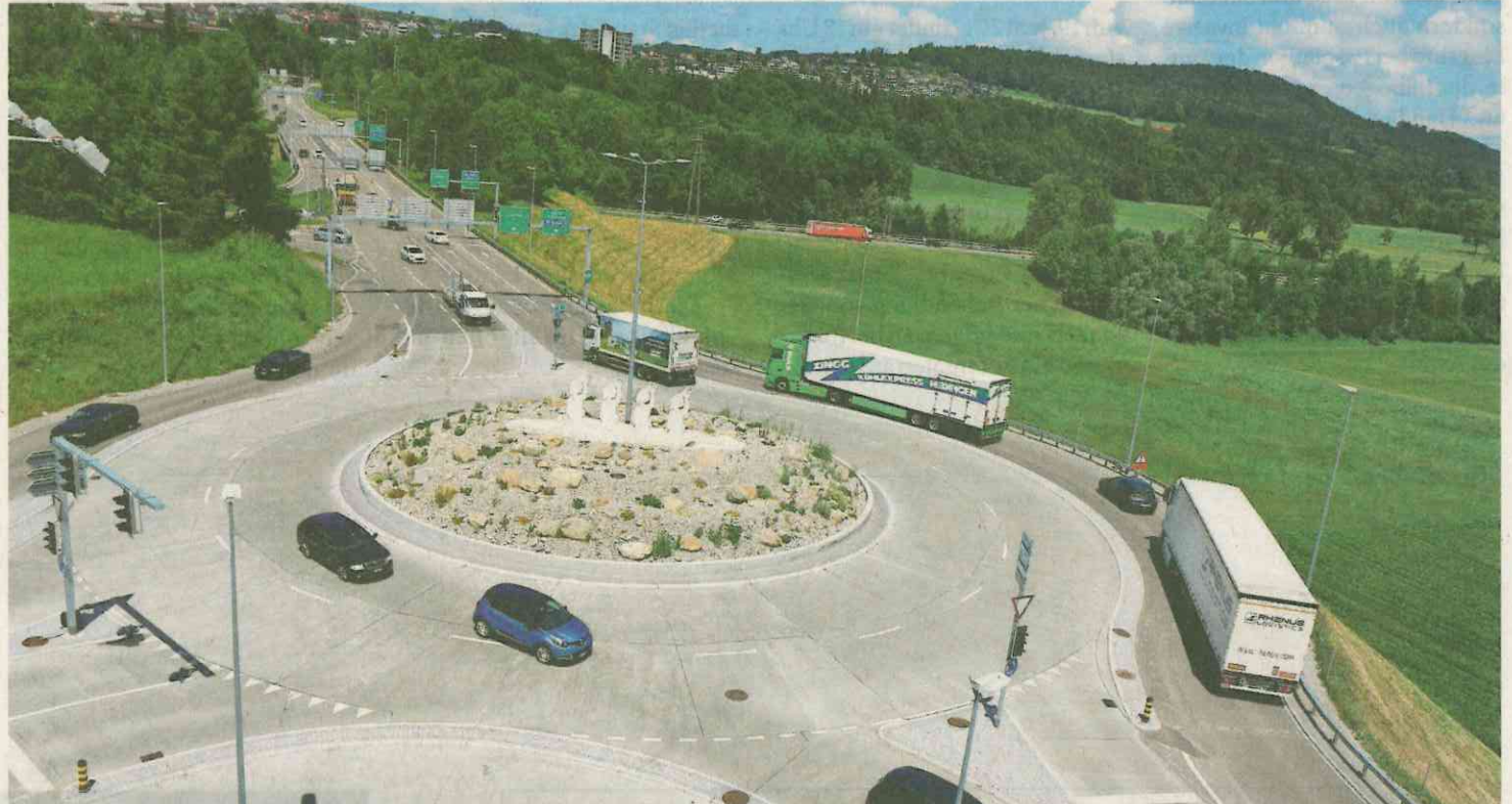
Wer in den Kreisel einfahren will, muss den bereits im Kreisel befindlichen Verkehrsteilnehmern den Vortritt gewähren. Dem Bypass, der vom Toggenburg auf die Autobahn A1 Richtung Zürich führt (Spur ganz rechts), wurde das Vortrittsrecht entzogen. Bild: Hans Suter
