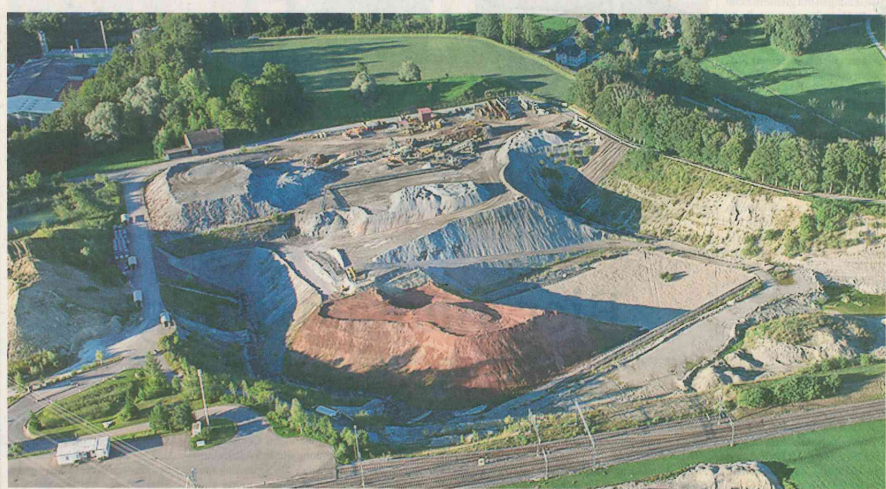
Dank des genehmigten Ausbaukredits können direkt neben der Bahnlinie Wil-Gossau ein weiteres Jahrzehnt Abfälle aus Verbrennungsprozessen gelagert werden.
