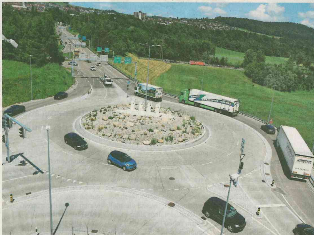
Realisiert: Im Oktober 2016 wurde das neue Verkehrsregime mit den neuen Doppelkreiseln bei der Autobahnzufahrt Wil in Betrieb genommen und dem Verkehr übergeben. Im Bild der Wilfeldkreisel. Bild: Hans Suter
