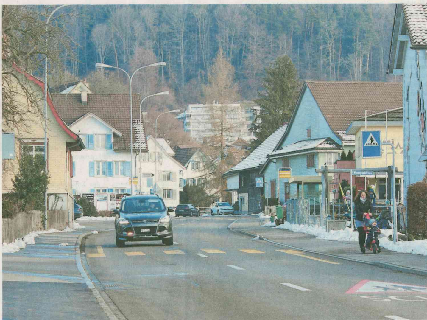
Die Unterdorfstrasse ist in einem schlechten Zustand und soll im Jahr 2019 saniert werden.
