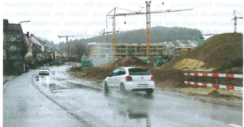
Hörnlistrasse in Richtung Kreisel. Auf der rechten Seite im Bau befindliche Wohn- und Geschäftsliegenschaften.
