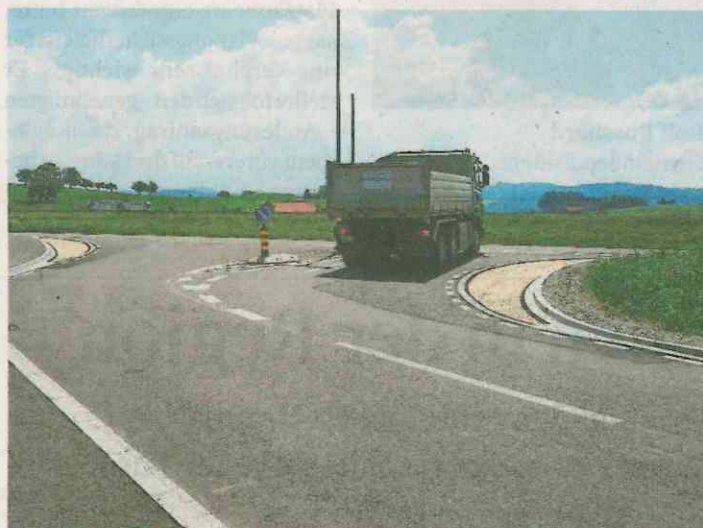
Die Fahrzeuge sollen sich beim Abbiegen hintereinander aufstellen.
