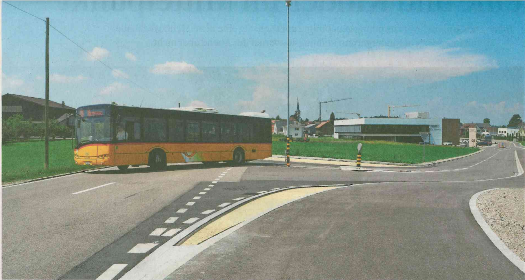
Mehr Komfort für Postauto-Fahrgäste: Seit die erhöhten Überfahrflächen abgetragen wurden, gibt es bei Niederwil kein Geholper mehr.
