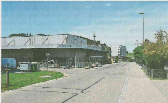
Die neue Haltestelle kommt an der Oberhofenstrasse auf Höhe der Pumpwerkstrasse zu stehen. Bild: Roman Scherrer
