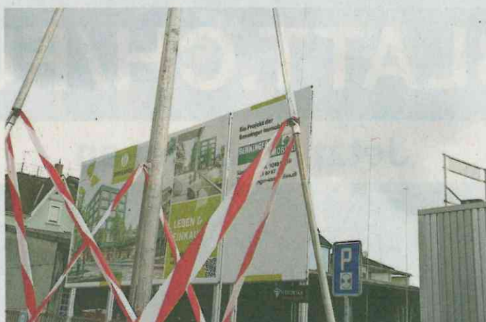
Visiere lassen die Dimensionen des Bauvorhabens innerhalb des Benninger-Areals erahnen.
