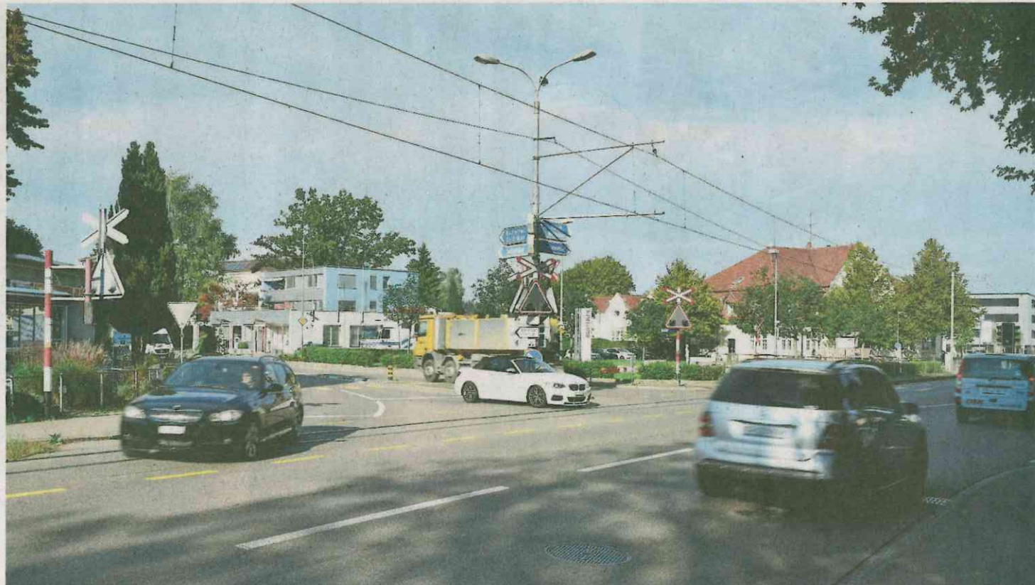
Die stark befahrene Kreuzung Frauenfelder-/Eschlikonerstrasse mit dem Bahngleise der Frauenfeld-Wil-Bahn.
