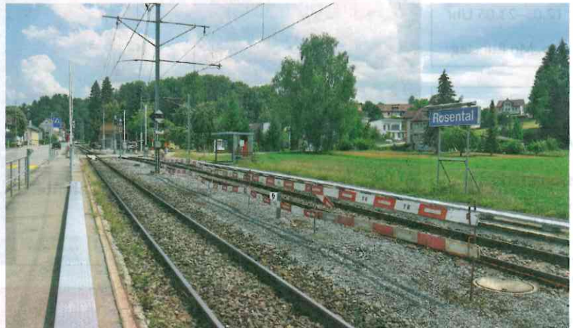
Bisheriger Zustand der Haltestelle Rosental. Der Umbau zu einer behindertengerechten Haltestelle findet noch bis Ende November statt.
