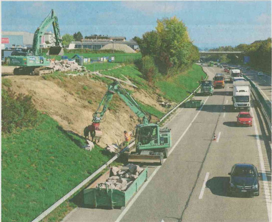
Autobahn A1: Zur Verhinderung von Ausschwemmungen wird das Bord mit Steinen befestigt. Bilder: Hans Suter
