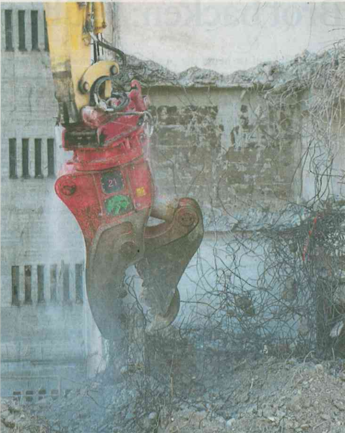
Mühle Rickenbach: Mit 1500 Tonnen Kraft gegen Stahlbeton.
