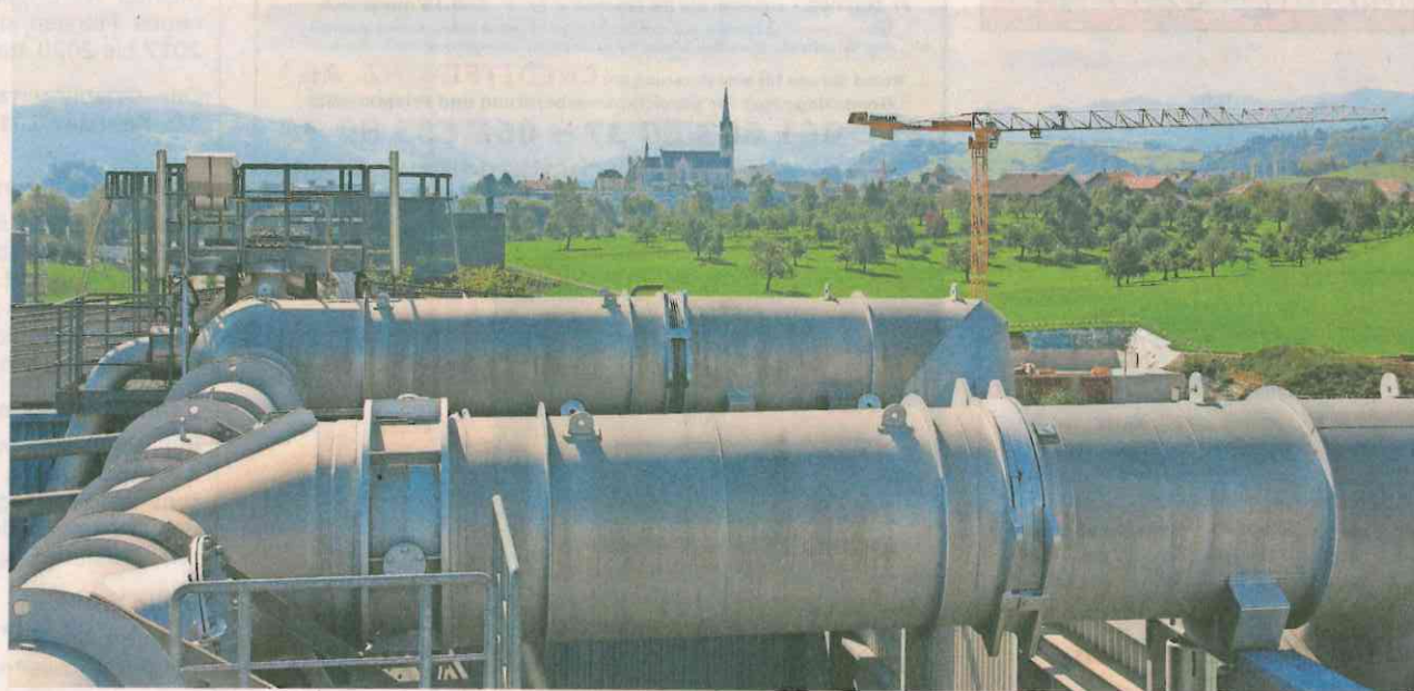
Die Stadt Wil soll bald auch durch das Fernwärmenetz mit Wärme aus Bazenhaid versorgt werden.
